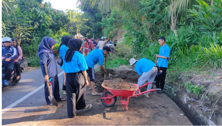
Gambar 1. Pembersihan Sediment pada jaringan irigasi & jalan
