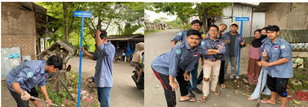
Gambar 2. Pemasangan plang dusun
